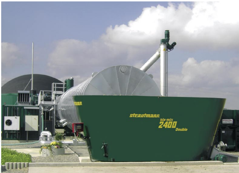
Optimales Befüllen von Beton- und Metallfermentern
